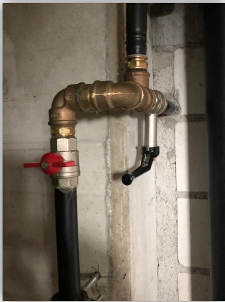
Wasserhähne bei Betrieb (rot geschlossen, schwarz offen)
